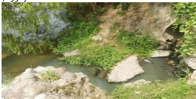
Figura 1. Punto de descarga del agua residual
