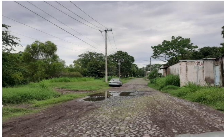
Figura 3. Escasez de banquetas en las vialidades cercanas a la central. Archivo personal.
