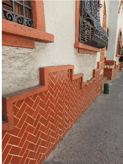
Figura 5. “Línea de fachada con sobresalientes, obstaculizando el IPA en tramo 04”.
