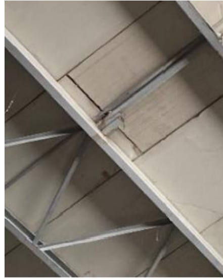
Figura 16. Lesiones físicas y mecánicas encubierta de acero. Fuente: elaboración propia, 2022.
