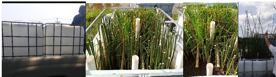
Figura 2. Humedal construido con planta carrizo como soporte
