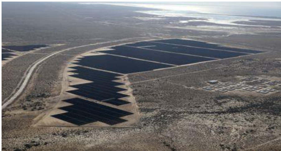
Figura 5. Planta fotovoltaica de Puerto Peñasco. La planta tiene una superficie de 2,000 hectáreas y proveerá energía a los estados de Sonora, Chihuahua y Sinaloa
